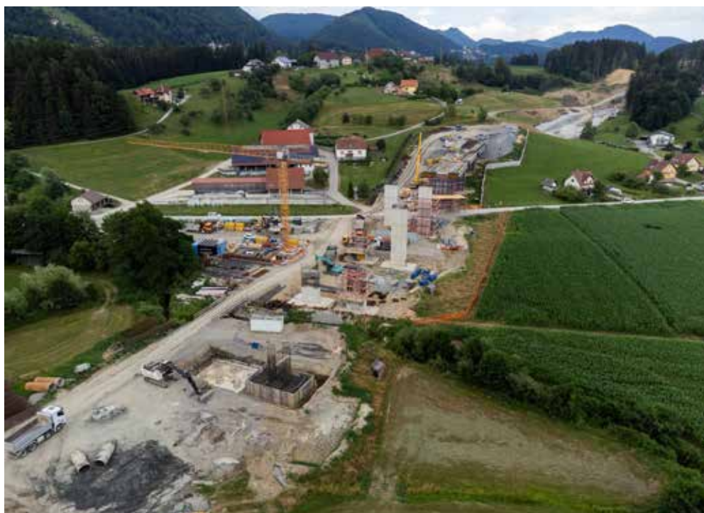
Gradnja severnega dela 3. razvojne osi. Foto: Dars
