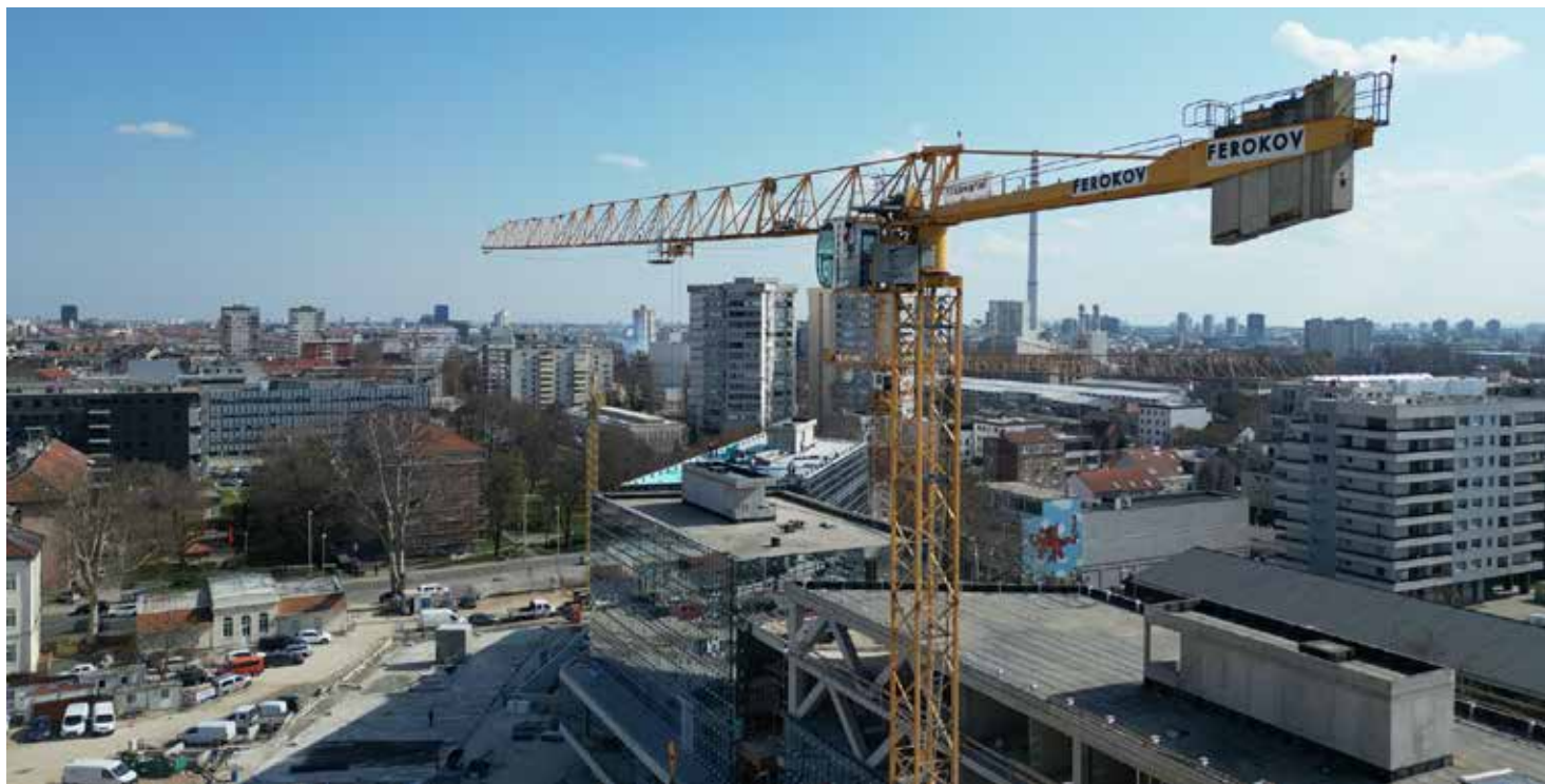
Žerjav družbe Ferokov na gradbišču na Trgu pravde v Zagrebu. Foto: Ferokov Gradbeni žerjavi d.o.o
