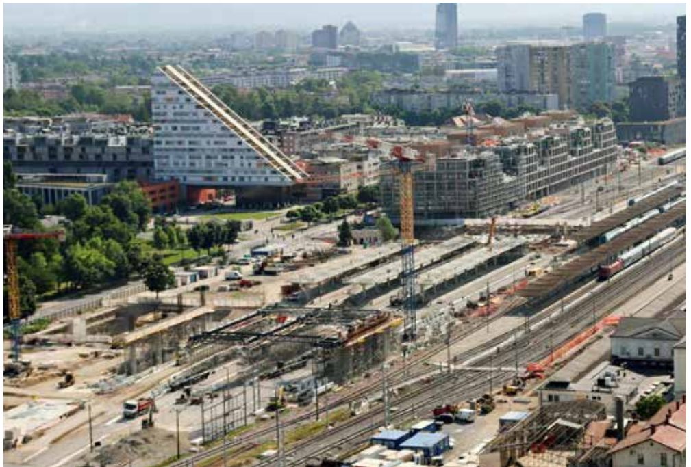
Nadgradnja osrednjega dela železniške postaje Ljubljana. Foto: Direkcija RS za infrastrukturo
