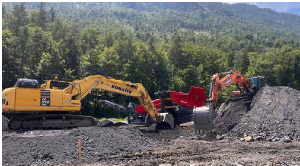
Sanacija zahodne cevi predora Karavanke. Foto: Dars
