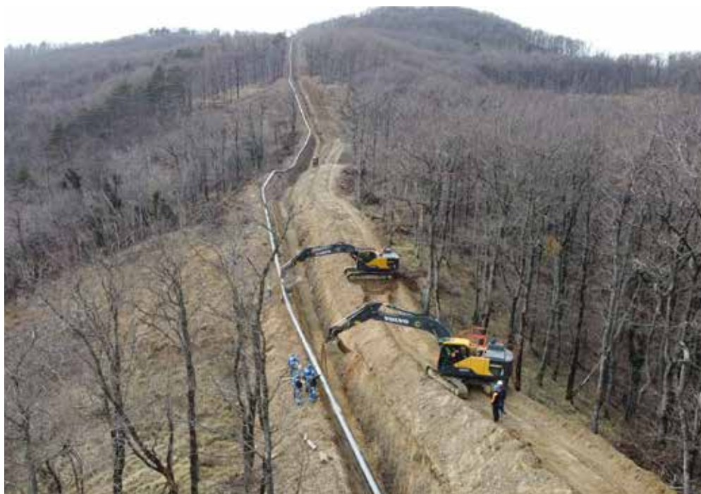
Gradnja Plinovoda M6. Foto: Plinovodi
