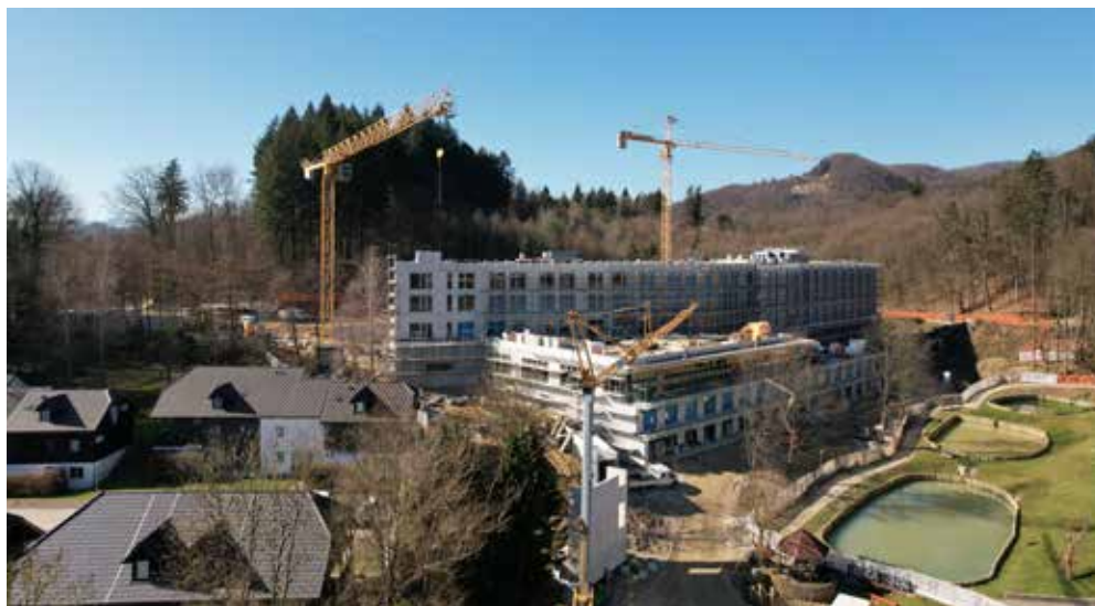
Žerjava podjetja Ferokov na gradbišču v Termah Olimia v Podčetrtku. Foto: Ferokov
