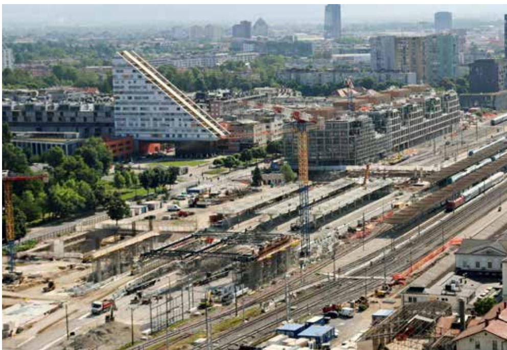
Nadgradnja osrednjega dela železniške postaje Ljubljana. Foto: Direkcija RS za infrastrukturo
